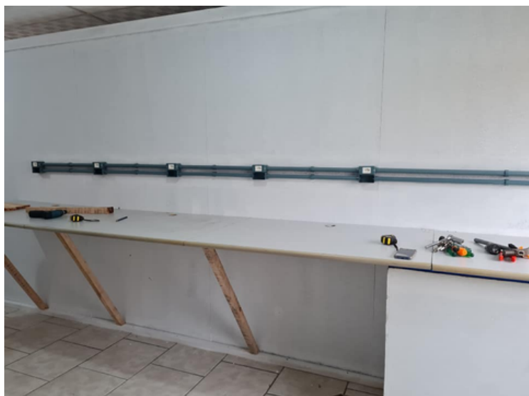
Centro de restauração de computadores - CRC em construção e acabamento. 10/09/2021
